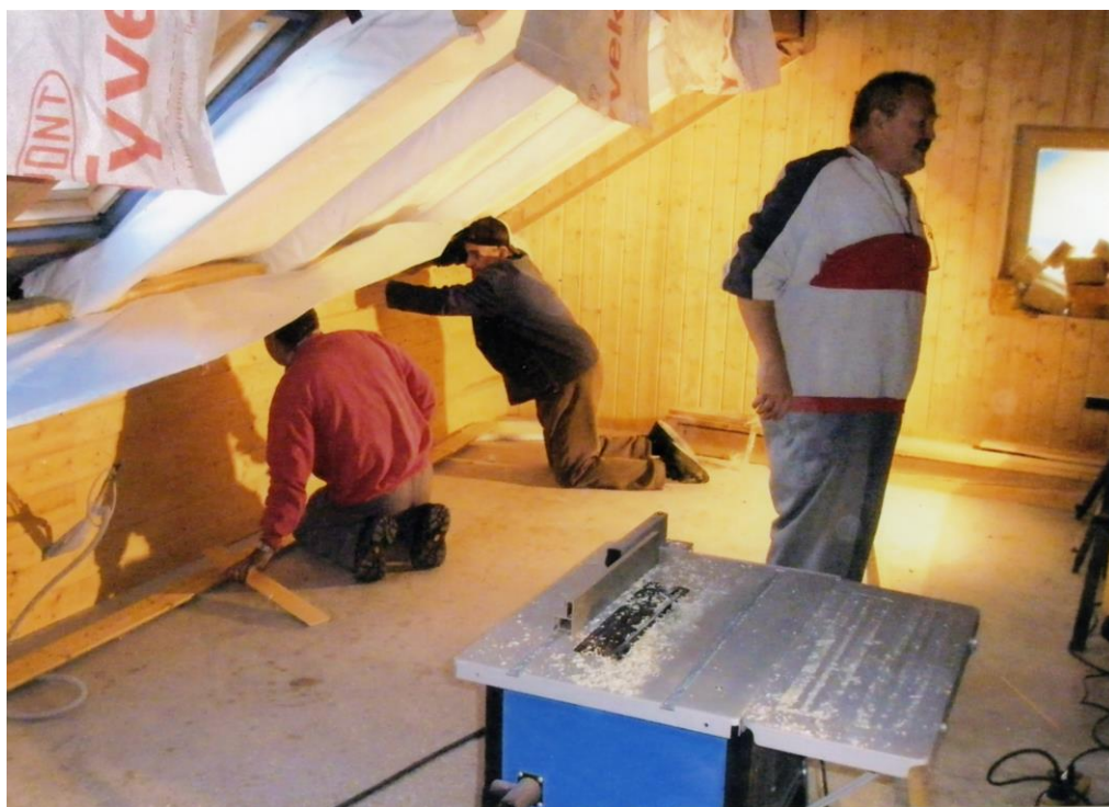
Proti koncu gredo dela v dvorani
