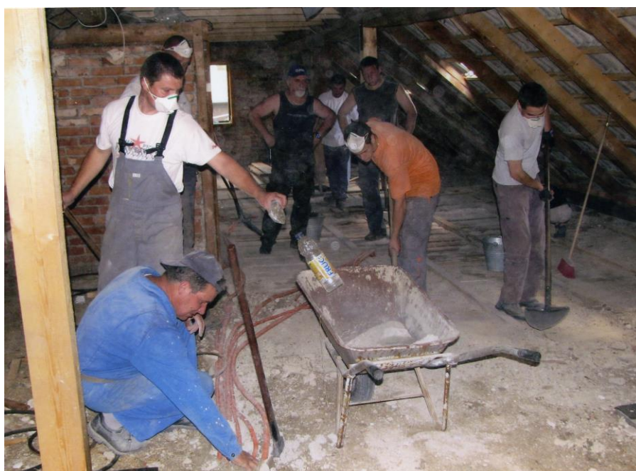
Začetek del pri gradnji dvorane, na podstrešju gasilskega doma
